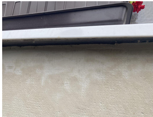
parapet neдрží na podkladu
