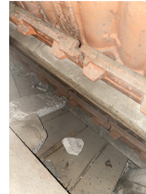
střecha tepelná izolace
