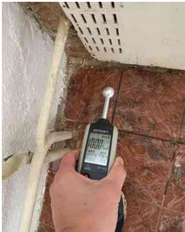
Spodní úroveň - Vlhkost >24%
