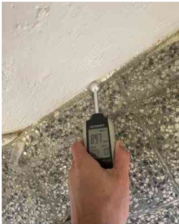
Spodní úroveň - Vlhkost 20%
