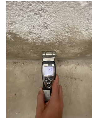
Měření vlhkosti sklep
