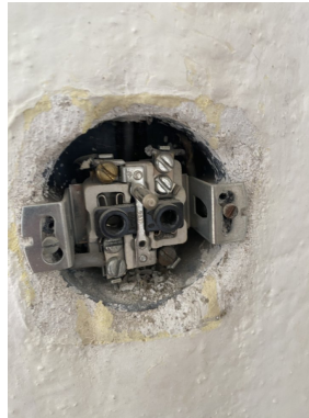
Hliníkové vodiče v zásuvkách
