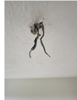
Hliníkové vodiče pro světlo, izolace je opálená
